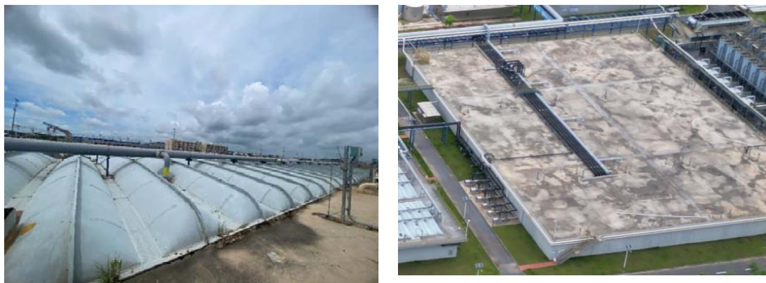
图6.2-1 项目构筑物密封加盖实景图（左为生化组合池、右为调节池）
