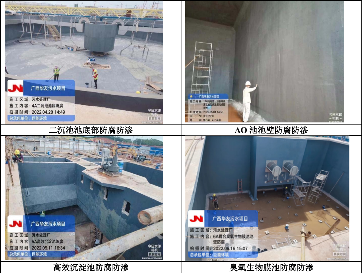
图6.2-7 项目现有工程重点防渗区建设情况
