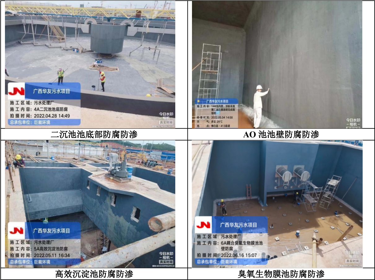
图2.1-3 项目重点防渗区建设情况
