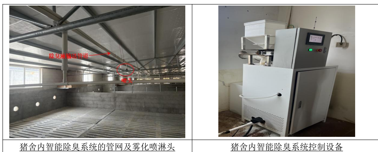
图 6.2-1 猪舍内智能除臭系统装置图例
