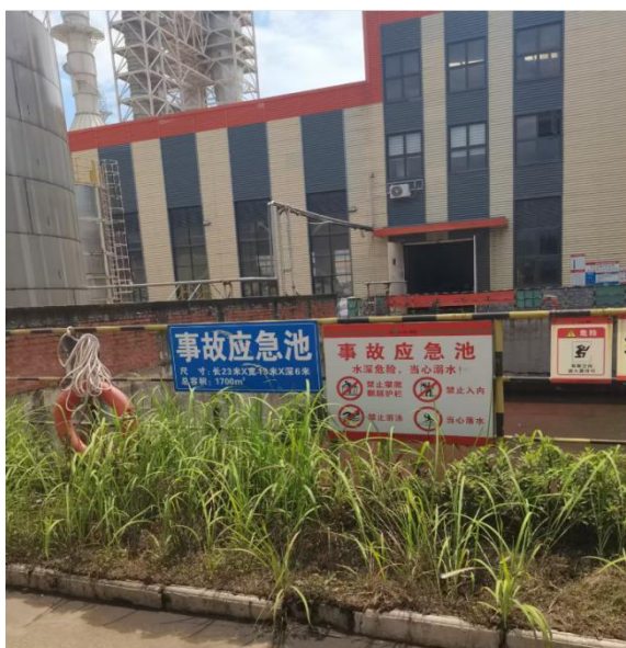
项目事故应急池
