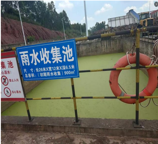
项目雨水收集池
