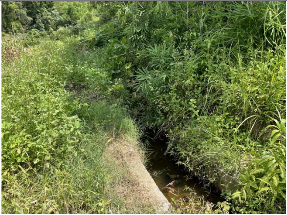
大坡支渠现状
