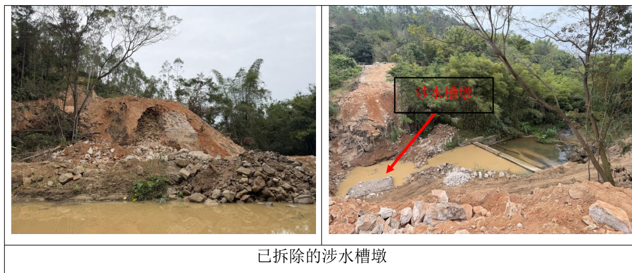
图 2.3-15 龙湾渡槽施工现状
