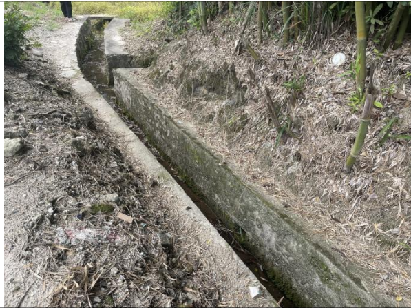
石窝干渠已做的“三面光”防渗
