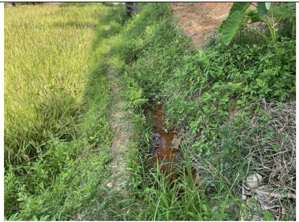
岭头坝需改造的渠道现状
