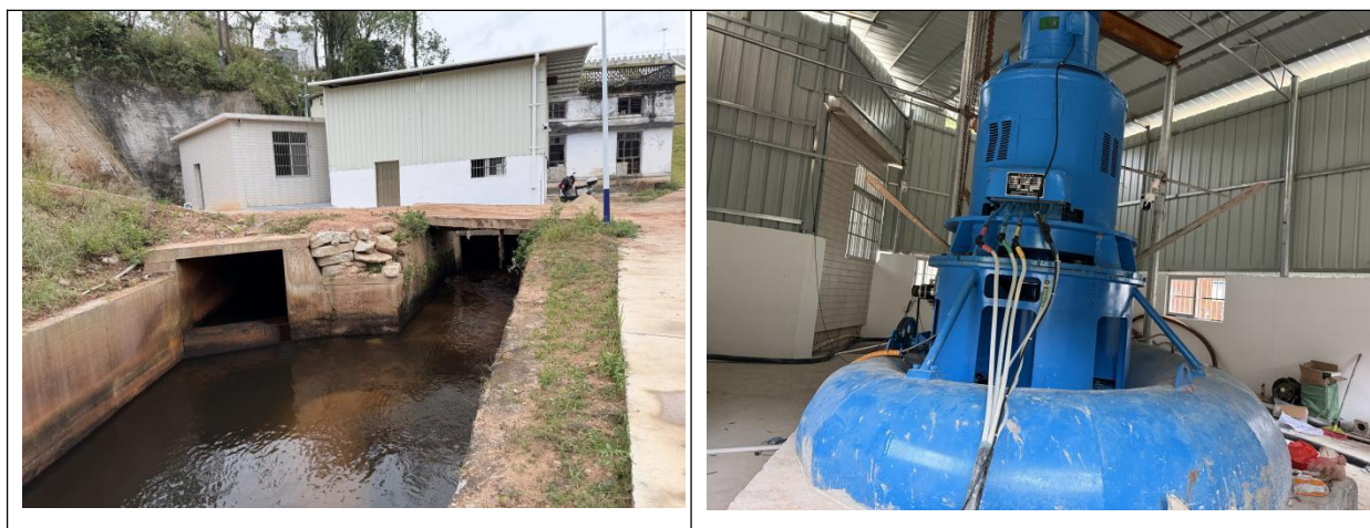
图 4.1-1 大贤水库坝后水电站整改现状图
