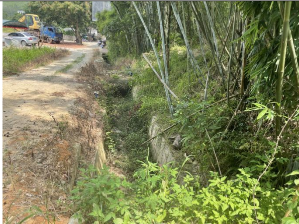
龙湾支渠现状
