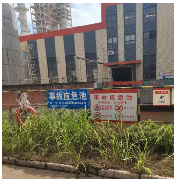
项目事故应急池
