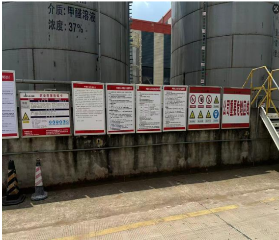
项目甲醛储罐
