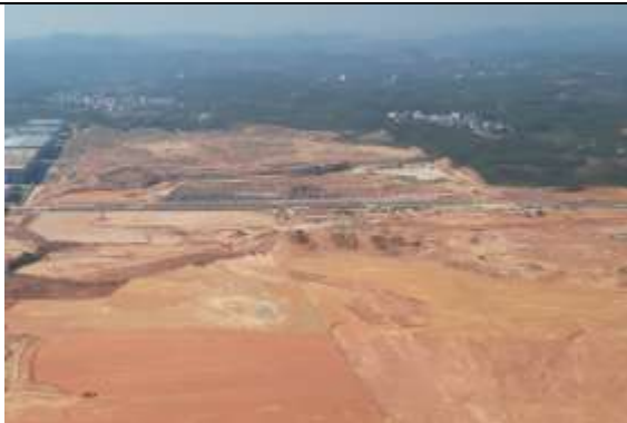
项目场址西面现状
