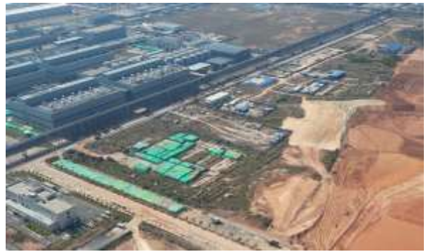
项目场址南面现状
