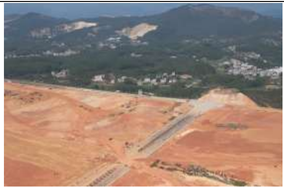
项目场址北面现状
