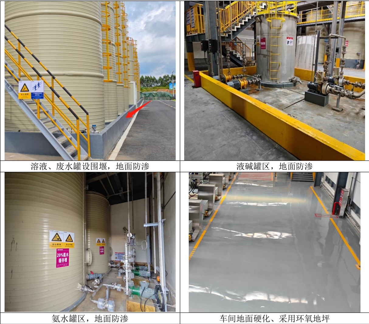
图 6.2-9 项目已建重点防渗区建设情况
