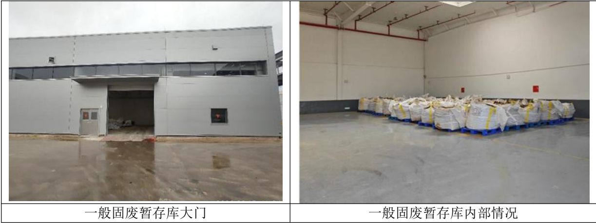
图 6.2-11 依托的时代新能公司一般固体废物暂存库现场图
