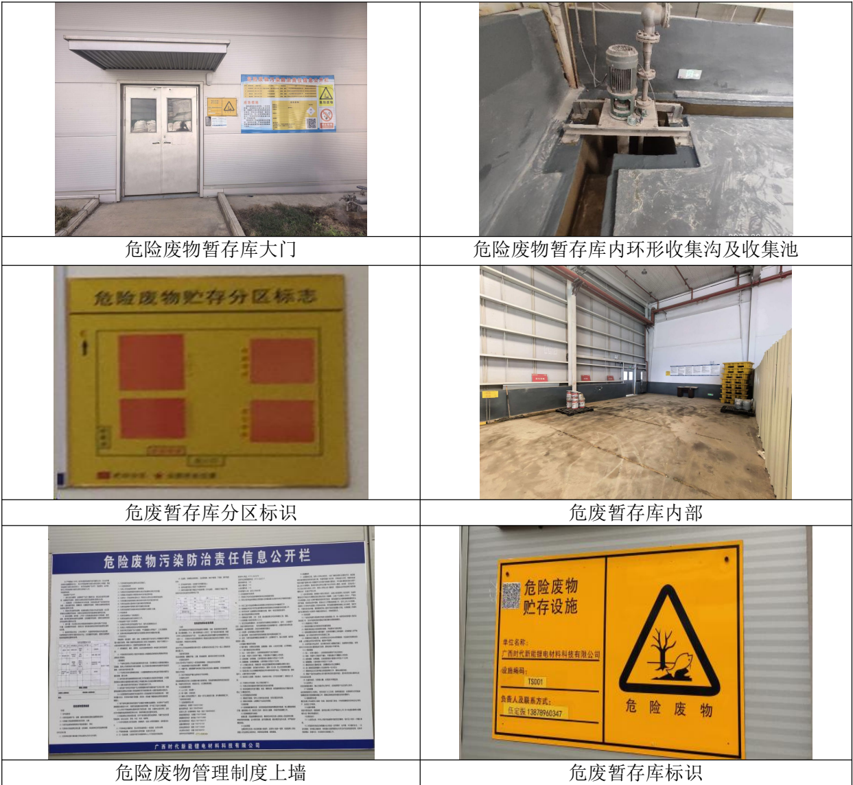
图 6.2-12 依托的时代新能公司危废暂存库现场图
